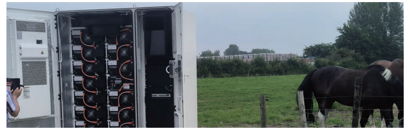
• 荷兰 DH200F 100kW/215kWh 光伏消纳 (自发自用)
