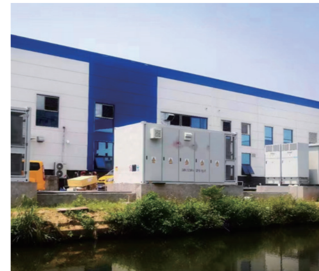
• 中国 DH200F 5MW/18MWh 动态扩容+光伏消纳
