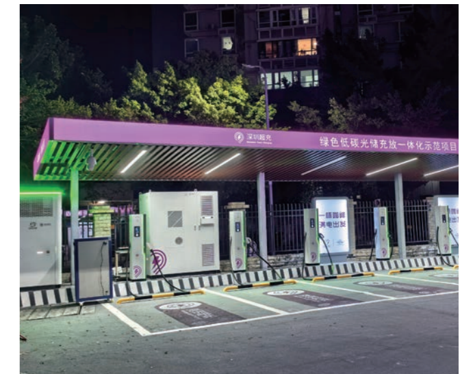
• 中国 DH200F 100kW/215kWh 峰谷套利+削峰填谷
