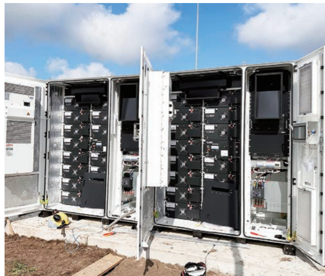
• 荷兰 DH200F 200kW/430kWh 动态扩容 (peak-shaving) + 光伏消纳 (自发自用) + 充电桩
